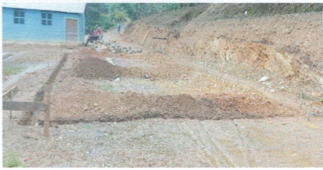
Foto1: Zanjeado del área de remorzar
