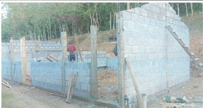
Foto 4: Paredes de Block
