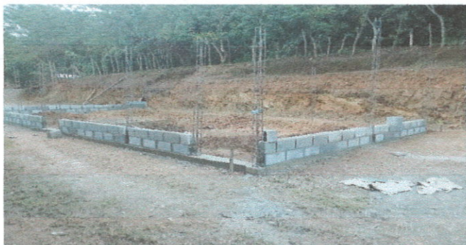
Foto 2: Colocación de columnas de hierro
