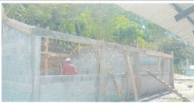
Foto 5: Paredes de Block
