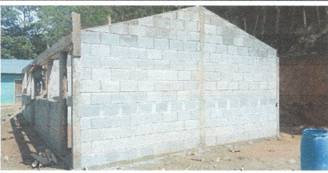
Foto 6: Paredes de Block
