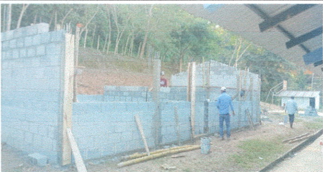
Foto 3: Paredes de Block
